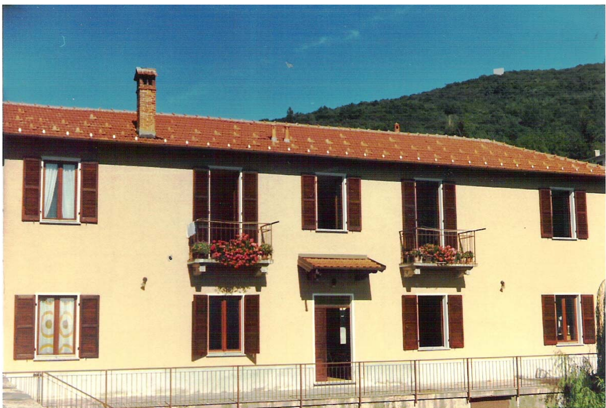
1982 - Casa parrocchiale e salone dell'oratorio restaurati
