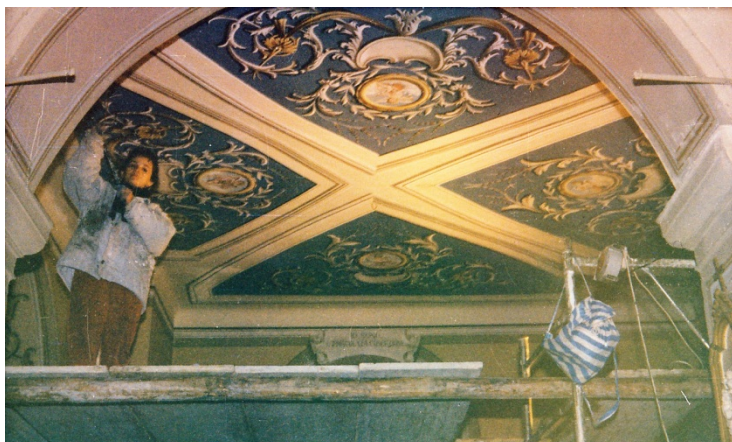
Lavori di restauro Cappella della Madonna
