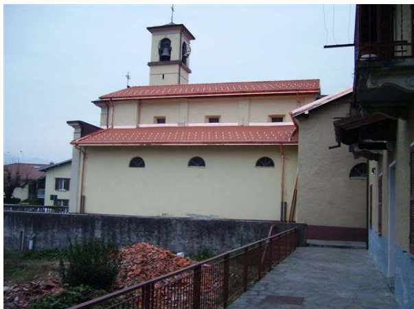
Tetto della chiesa rifatto
