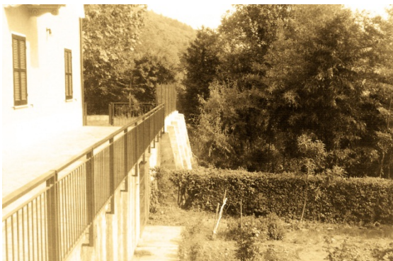
Barbacani di sostegno
