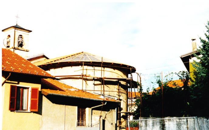
Rifacimento del tetto dell'abside
