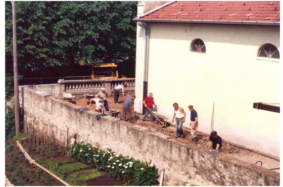
Sistemazione sagrato della chiesa
