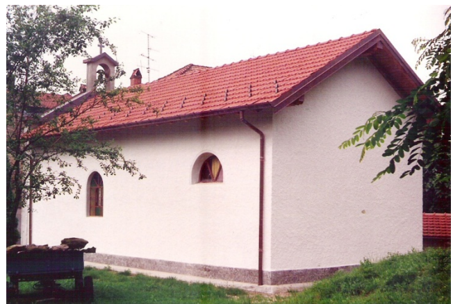
Situazione al termine dei lavori
